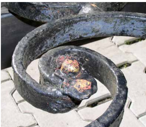
Der Zahn der Zeit hatte kräftig an den Rosetten an einem alten Geländer (linkes Bild) genagt. Im Zuge der Restaurierung wurden die Rosetten von Bernd Schnelle neu geschmiedet – was nicht nur handwerkliche Geschick, sondern auch Wissen über früher übliche Gestaltungsweisen erfordert.
